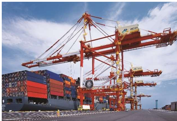
横浜港南本牧ふ頭のガントリークレーン (出典：JFE エンジニアリング株式会社 HP)
