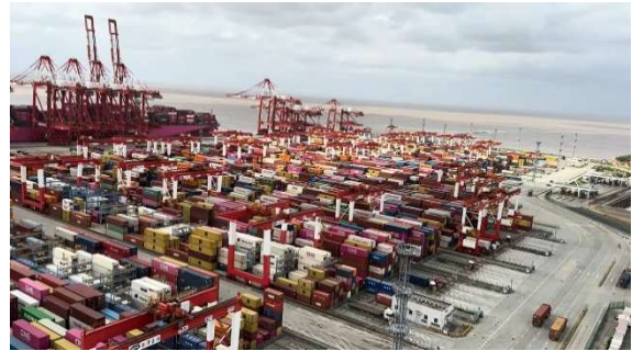
ターミナルの遠景
